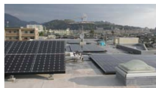
屋上のパネル124枚の設置風景
